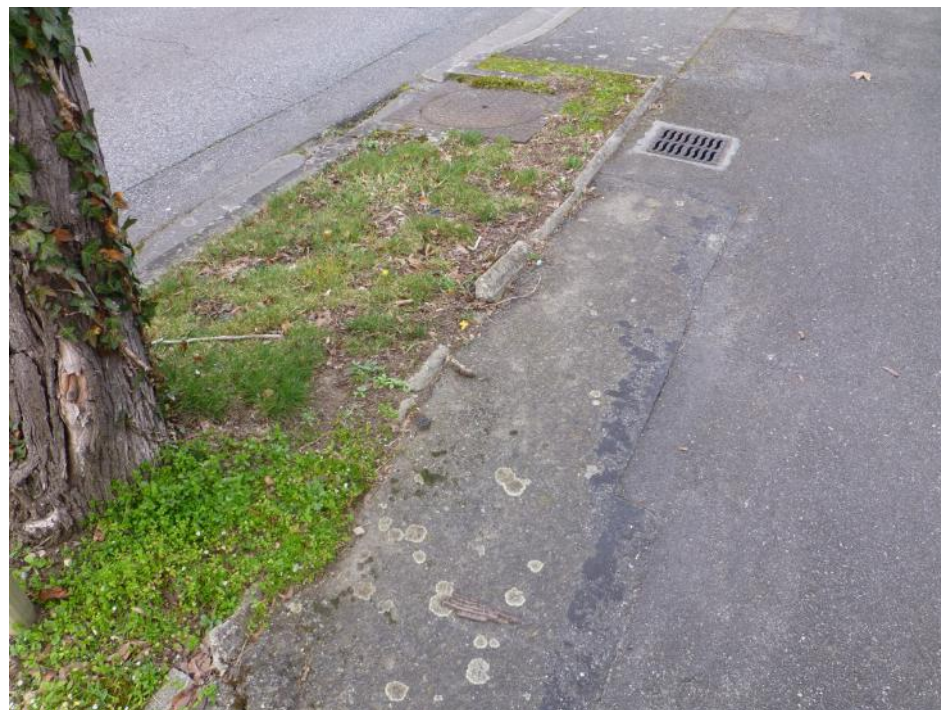
18-Revêtement soulevé par arbre au niveau du N°18
