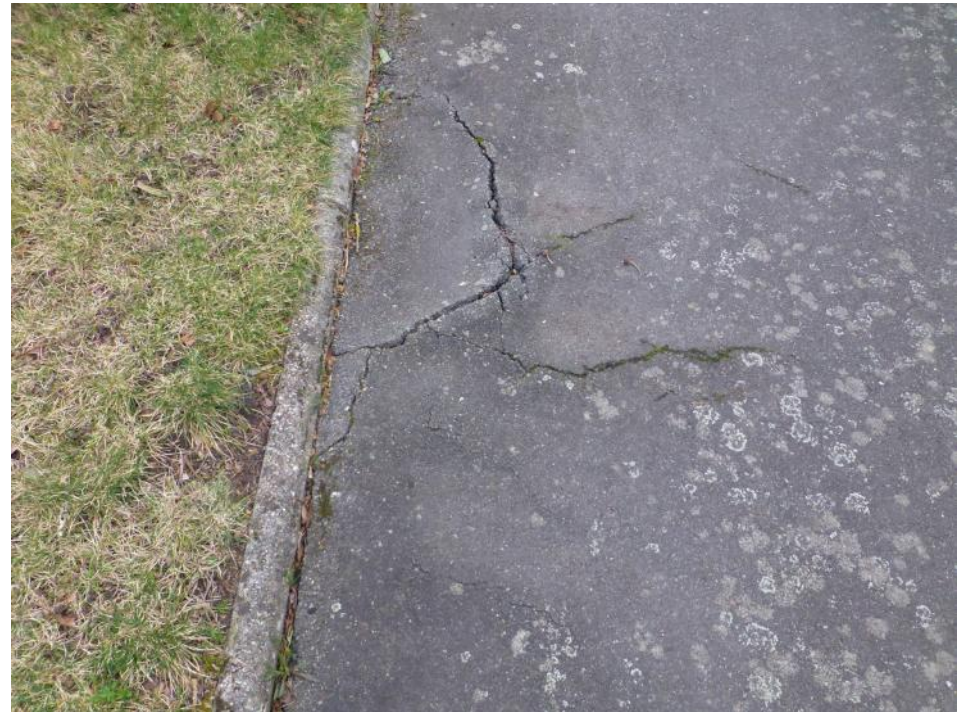
27a-Déformation du revêtement
