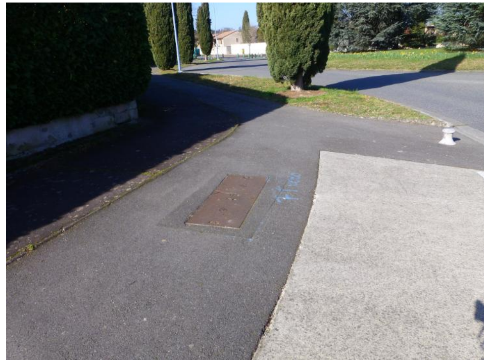
4- Plaque acier sortie de courbe
