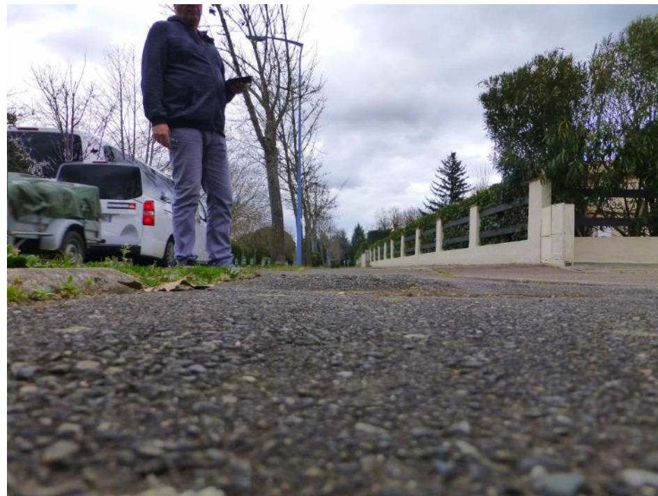
20-Grille écoulement pluvial en relief au niveau du N° 18
